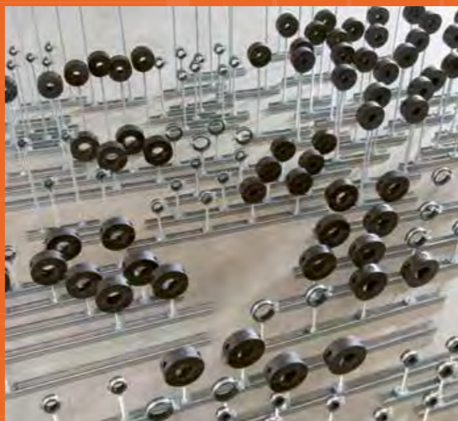
Vormontierte Trassen werden fertig auf die Baustelle geliefert.
