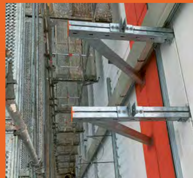
Vorbereitete Befestigungen an der Fassade
