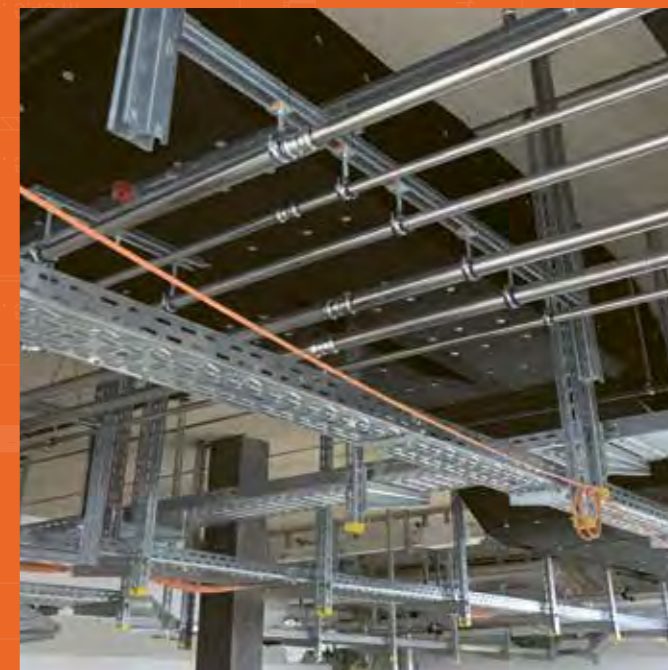
Blick an die Deckeninstallation
