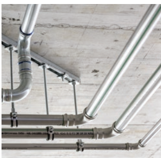
Aufhängung mit Montageschienen und Gewindestangen
